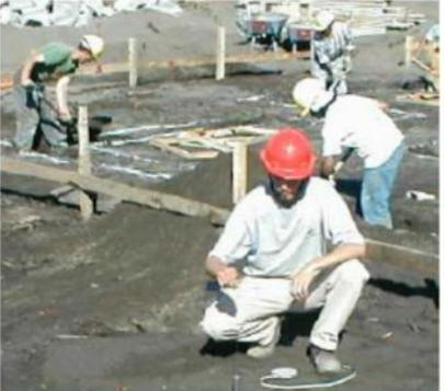
Por medio de lienza y plomo traspasar ejes de excavación a terreno.
