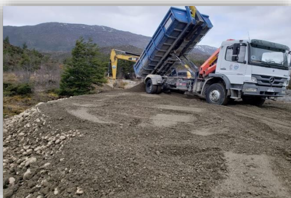
Traslado de áridos para plataforma y emplazar miradores. Villa O'Higgins, Año 2020.
