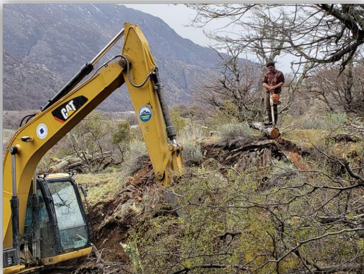
Construcción de caminos a Pobladores de Sector Mayer. Sector Mayer, Villa O'Higgins, Año 2020.
