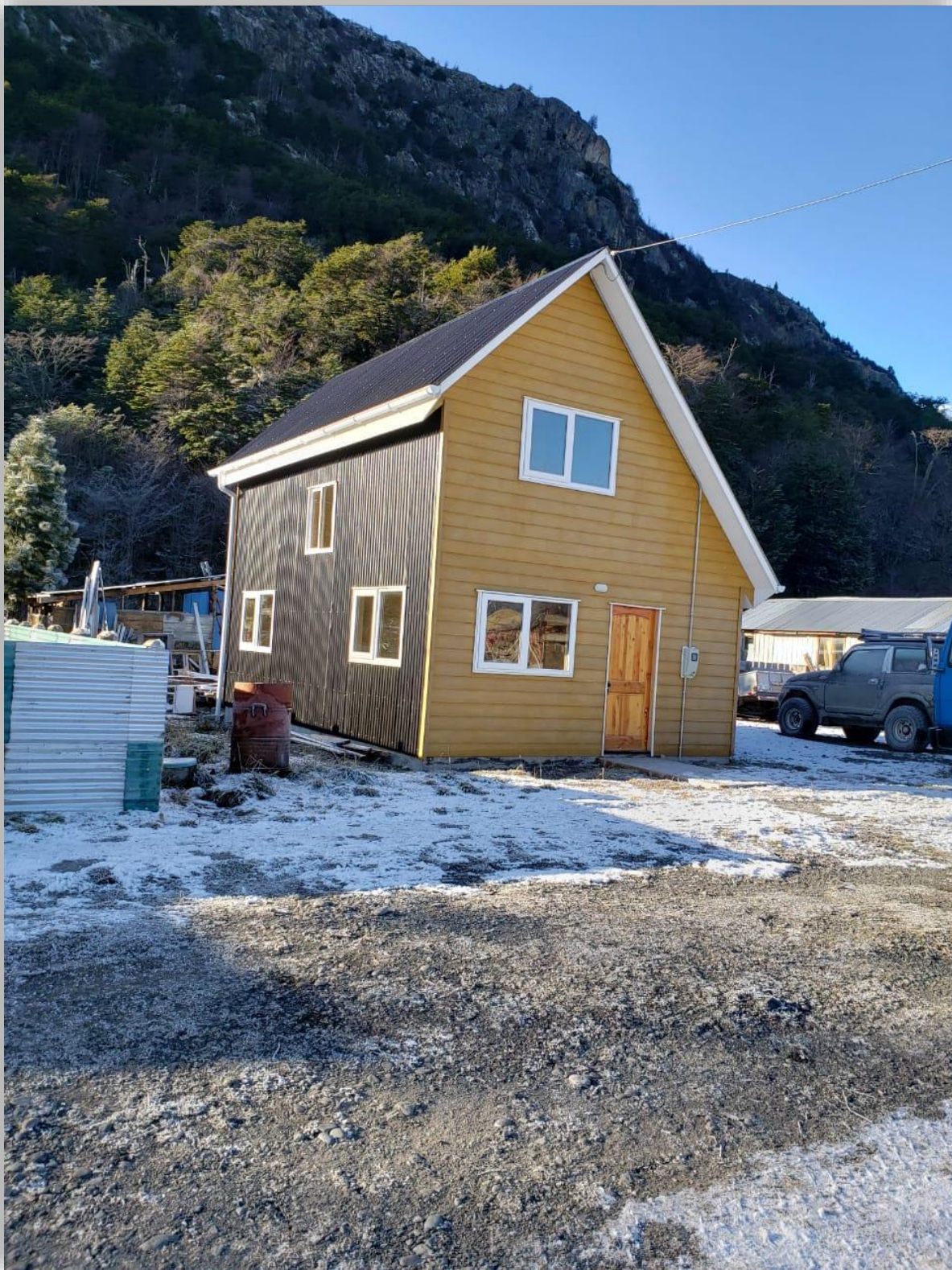
Primera Construcción de vivienda en sitio propio. Villa O'Higgins, Año 2020.
